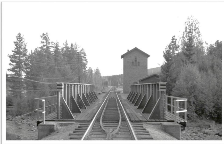
Balkbron över Svartälven i Sågen och Vattentornet. (se även foto på bron nedan), 1969.
