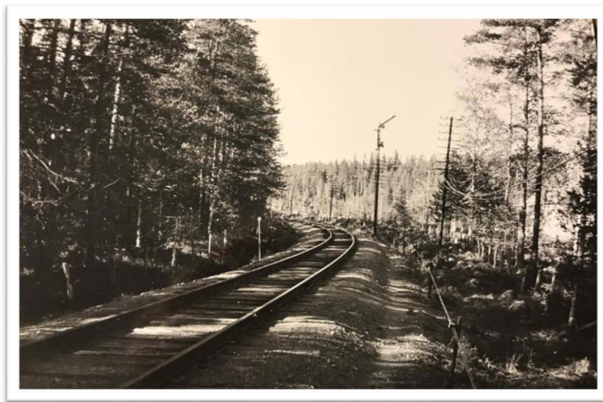
I närheten av Sågen 1969. Se vilken ogräsfri banvall. Foto: Hans Keller
