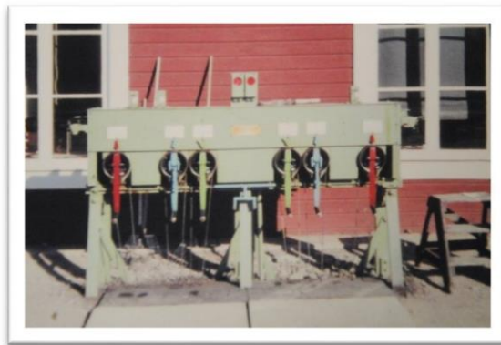
Bild 135 - Ställverk i Sågen. Liknande det som fanns i Vakern. Foto: Nils Erik Jansson
