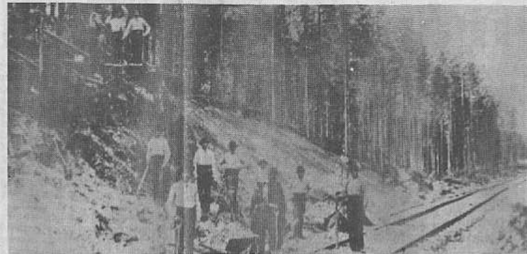
Då skenläggningen nådde Vansbro i mitten av augusti 1890 var snickarna långt komna med uppförandet av Jernvägshotellet och stationshuset, det senare syns längst bort. Stationen nedbrann 1898 och ersattes med nuvarande pampiga station av tegel.
